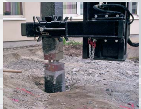
Соединение свай, первая свая уже забита и соединяется со следующей свайей перед её забивкой
