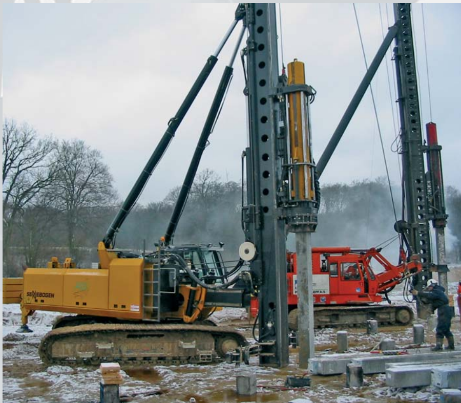
BANUT 650 с SuperRAM 6000 при строительстве свайного фундамента из готовых бетонных свай
