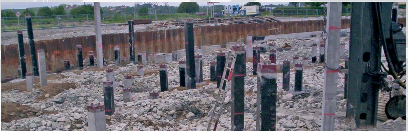
Подготовка строительной площадки с подготовленными бетонными сваями
