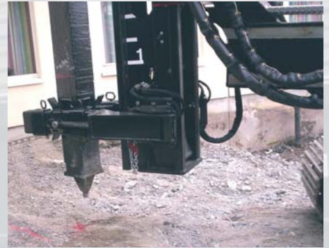
Гидравлически откидывающая направляющая сваи на мачте копра BANUT; позиционирование наконечника сваи
