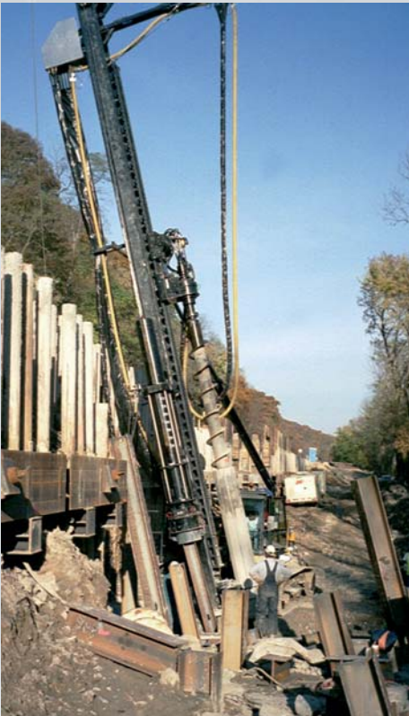
BANUT 650 при строительстве свайного фундамента для скоростной дороги в США
