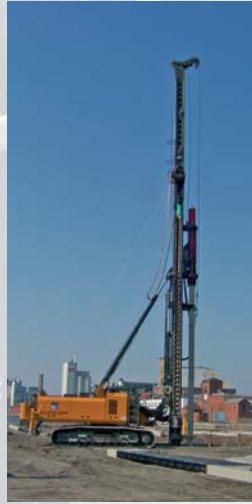
BANUT 650 с гидравлическим свободнопадающим молотом при забивке свай
