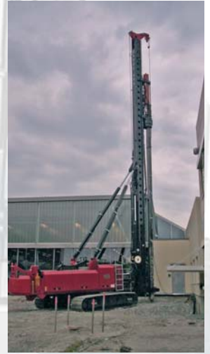
BANUT 555 с SuperRAM 6000 при забивке бетонных свай
