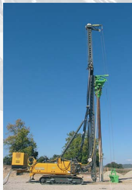
Копёр с жёсткой мачтой BANUT 650 со станцией при установке щебёночных столбов
