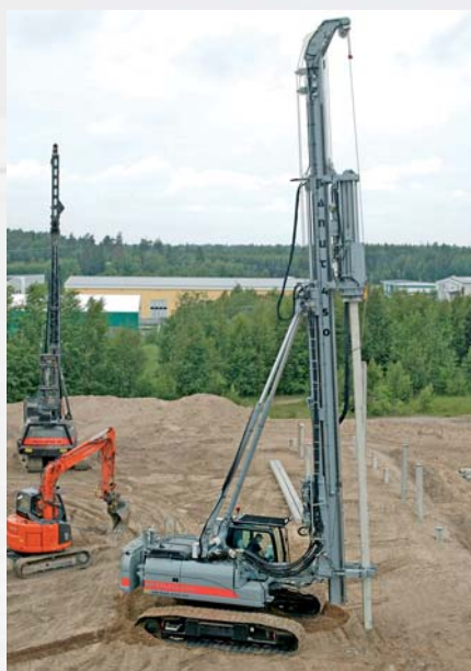
BANUT 450 с гидравлическим свободнопадающим молотом SuperRAM 5000 при забивке бетонных свай неподалеку от Стокгольма, Швеция
