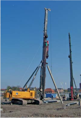
Вставка сваи в направляющую сваи при помощи вспомогательной лебёдки
