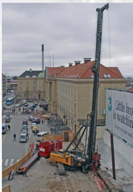
BANUT 650 со станцией при забивке шпунтовых профилей с традиционным вибропогрузителем в Оденсе, Дания
